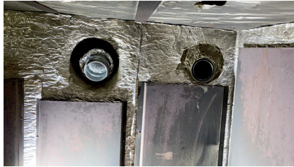
1 Nachdem der „Alte“ raus ist, wird der Anschluss für den Pellet-Heizeinsatz vorbereitet. Rechts der neue Rauchrohranschluss, links der neue Warmluftkanal für die 1. Etage.
