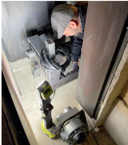
2 Jetzt wird das spezielle Traglager ausgerichtet und das Gebläse für das Multifuoco-System platziert.
