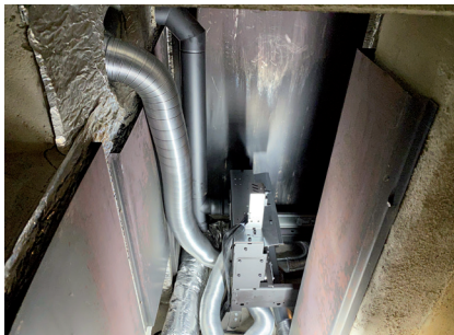
3 Danach werden die Flexschläuche für den Warmlufttransport eingepasst und angeschlossen.
